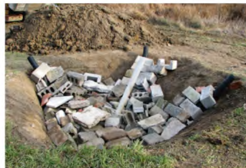
Hibernaculum en cours de construction
